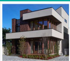
板橋区 成増展示場
